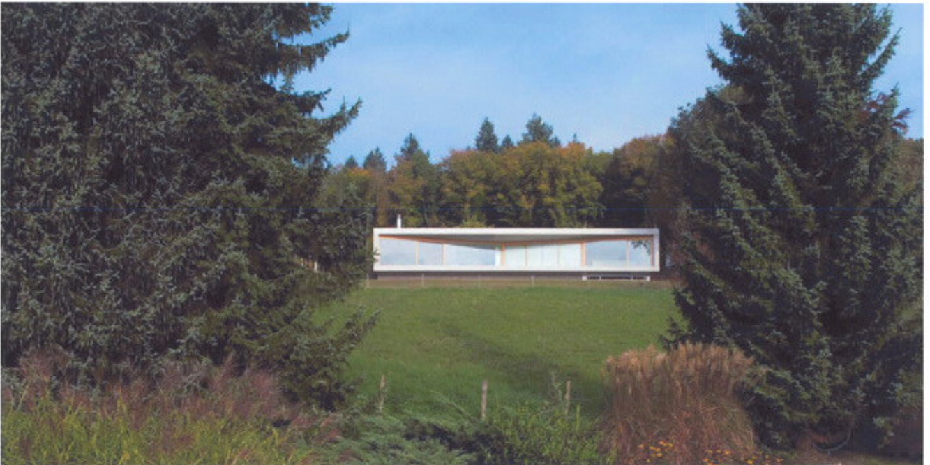
vue côté sud
